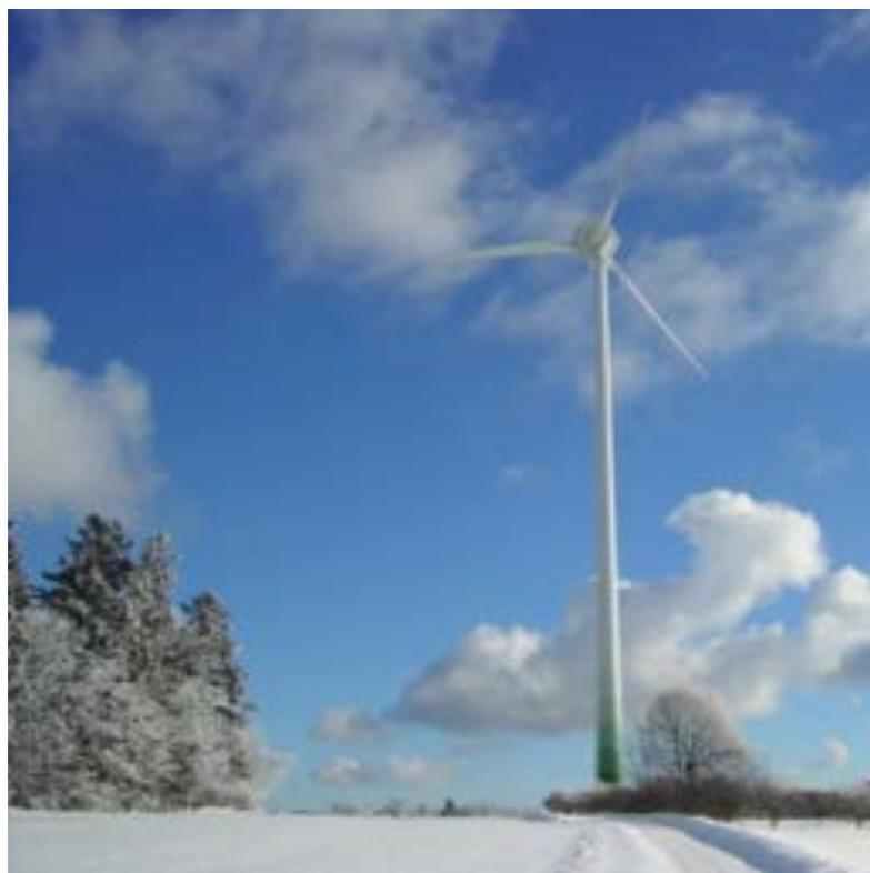
Abb. 9: Windenergieanlage unter Vereisungsbedingungen.
